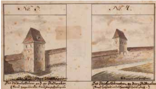
189 Mönchsturm (3) und Schiefertürmchen (4) 189 Baszta Mnisza (3) i baszta pokryta łupkiem (Schieferturm) (4)
